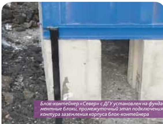
Блок-контейнер «Север» с ДГУ установлен на фундаментные блоки, промежуточный этап подключения контура заземления корпуса блок-контейнера
