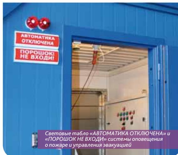
Световые табло «АВТОМАТИКА ОТКЛЮЧЕНА» и «ПОРОШОК НЕ ВХОДИ» системы оповещения о пожаре и управления эвакуацией
