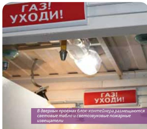
В дверных проемах блок-контейнера размещаются световые табло и светозвуковые пожарные извещатели
