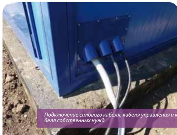
Подключение силового кабеля, кабеля управления и кабеля собственных нужд
