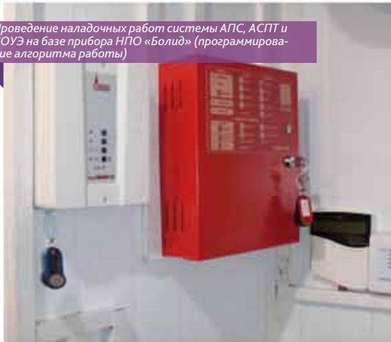
Проведение ПНР с имитацией проверки запуска модуля газового пожаротушения МГП-150 «АТАКА-1»
