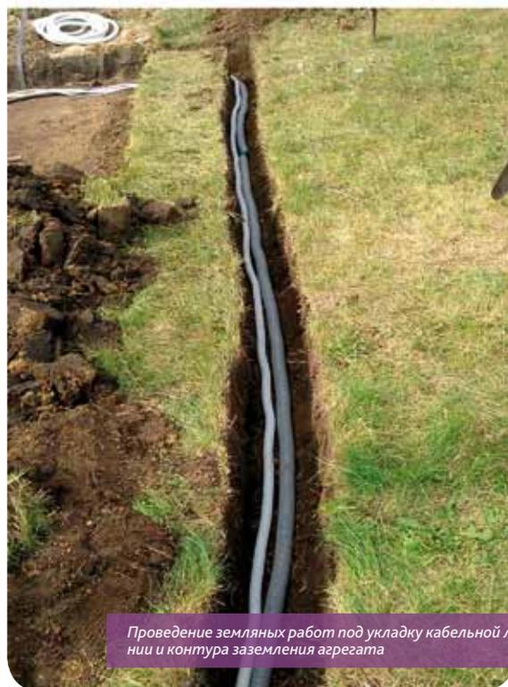
Проведение земляных работ под укладку кабельной линии и контура заземления агрегата
